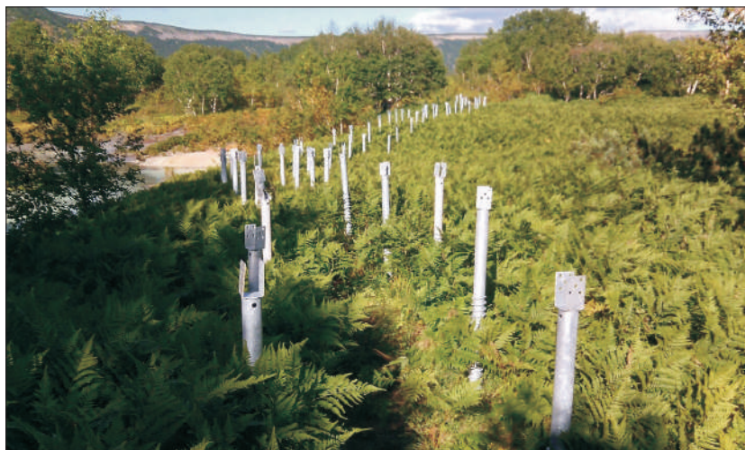
Рис. 2. Использование винтовых свай при обустройстве экологической тропы в Кроноцком государственном заповеднике
