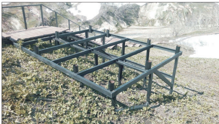
Рис. 3. Использование винтовых свай при обустройстве смотровых площадок в Кроноцком государственном заповеднике
