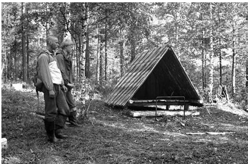
Строительство оборудованного кострища для туристов (В. Федоров и Д. Рыбников)
